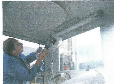
Prüfung der Erdung im Lampenbereich
