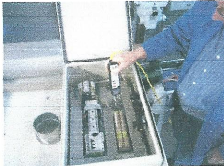
Prüfung der Schutzleiter-Kontakte im Schaltschrank
